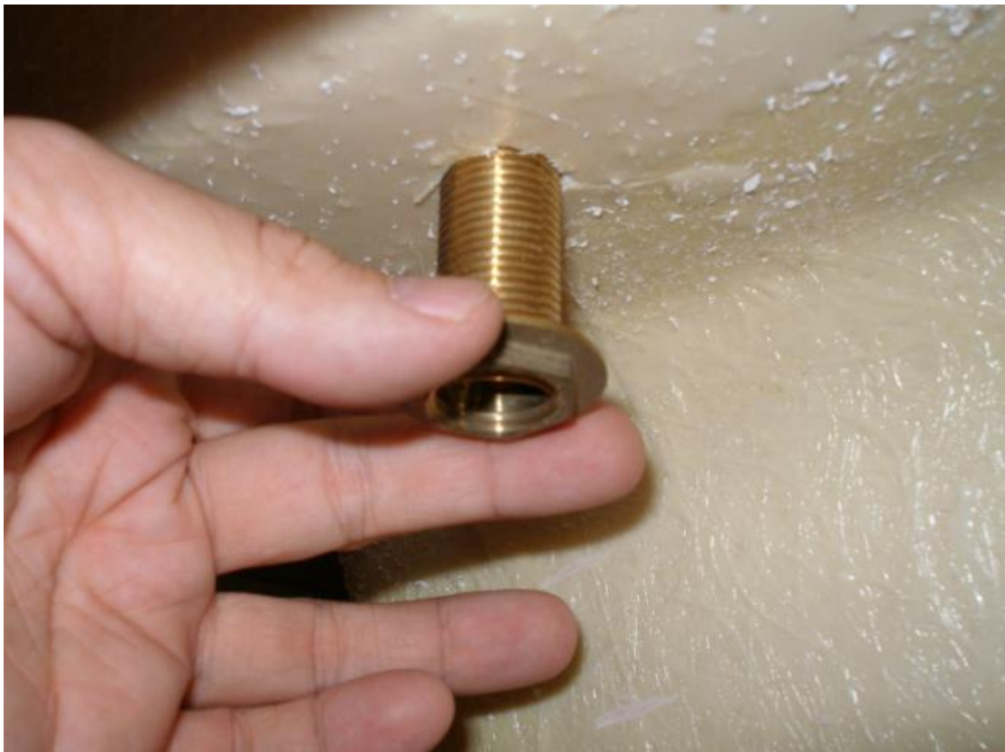
Bild 3 Skruva fast kranen underifrån med avsedd bricka
