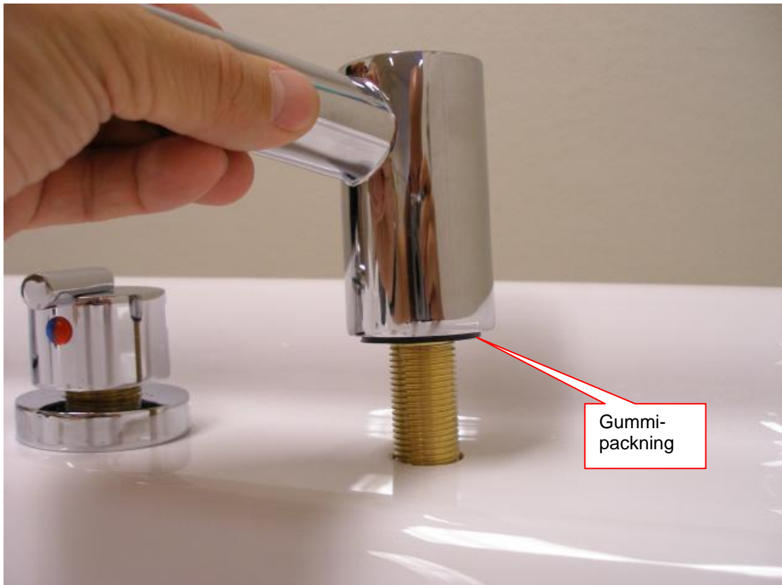
Bild 2 Trä på gummipackning och sätt i Kranen i avsett håll.
