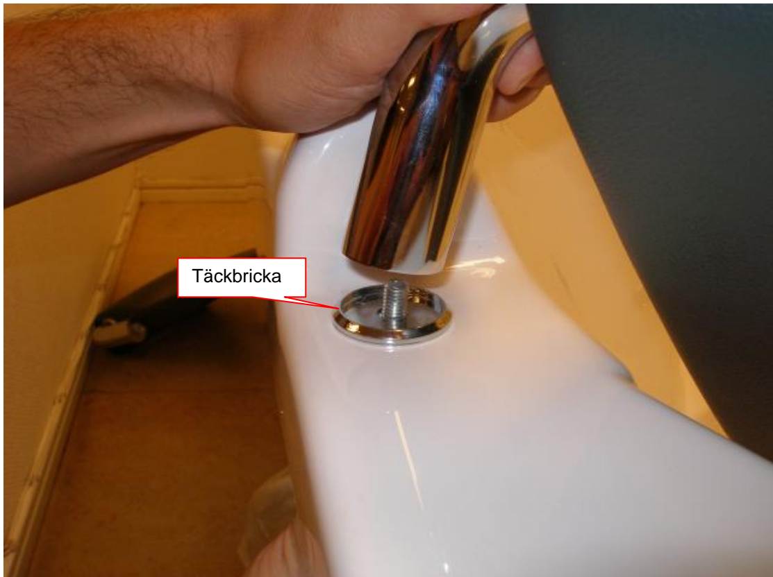
Bild 10 Trä skruvarna underifrån och skruva fast
